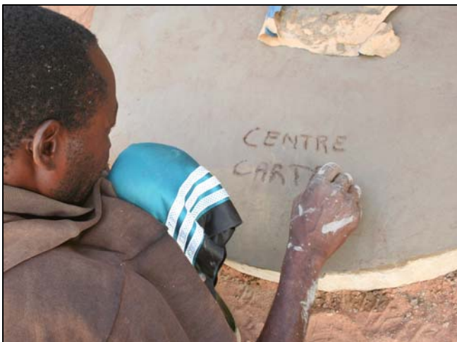
Un maçon (à gauche) termine une dalle de la latrine. A droite, une latrine est inspectée lors d'une évaluation des latrines.
